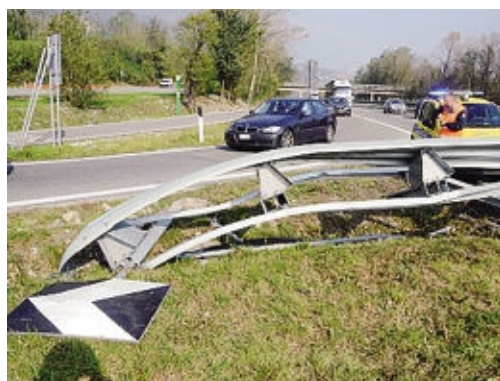
Il guard-rail distrutto dopo lo schianto
