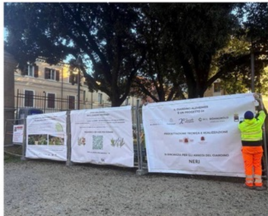
Il cantiere per la realizzazione del Giardino. A destra un'edizione della Maratona per l'Alzheimer
