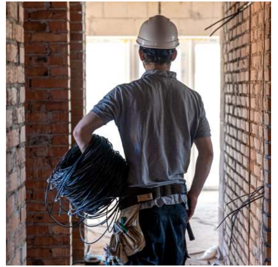
Un cantiere edile in un'immagine di repertorio
